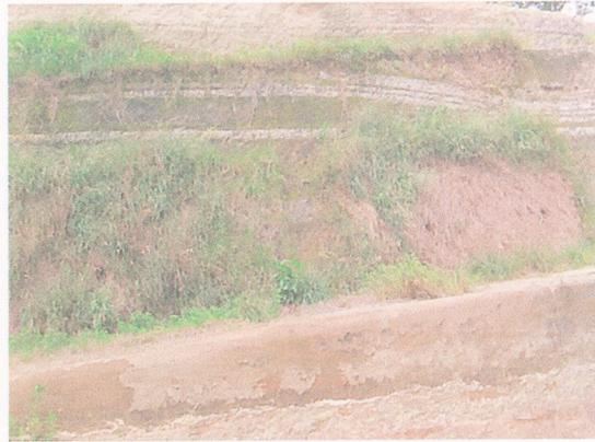
写真-9 1年後の緑化部比較 (左;樹皮使用, 右; 在来厚層基材)
