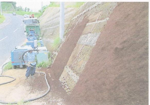
写真-5 手前は金網使用 (t=50mm), 奥は金網なし (t=30mm)
