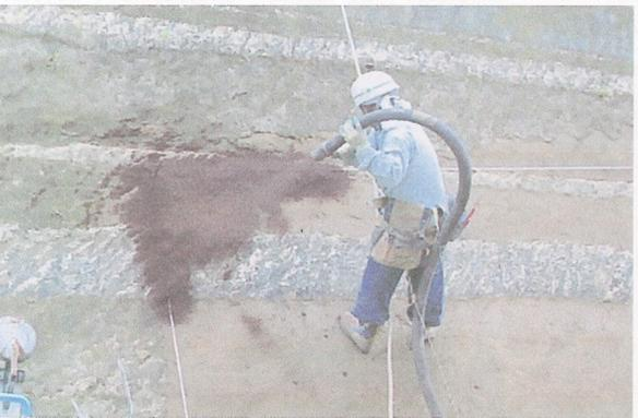
写真-4 樹皮繊維による吹付け (金網なし t=30mm)
