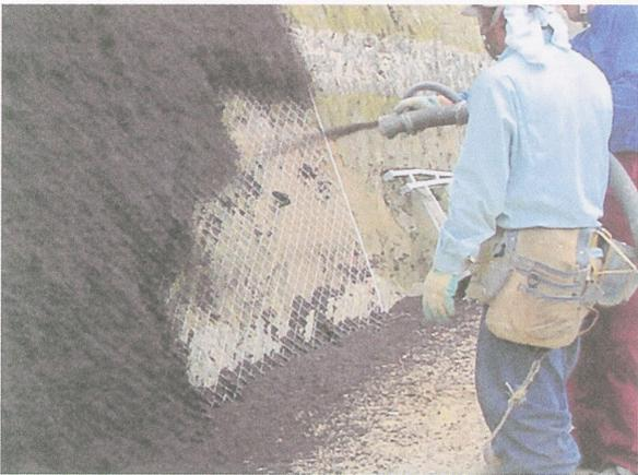
写真-3 金網へのジェット吹付け (t=50mm)
