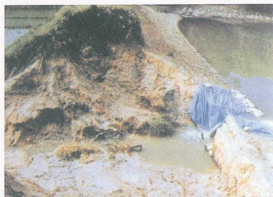
図-14 豪雨によるため池災害の事例 (決壊後)
