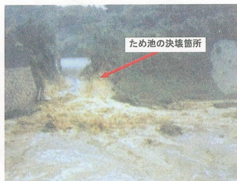
図-13 豪雨によるため池災害の事例 (決壊中の状況)
