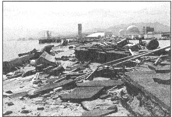
写真-2 広島県廿日市埋立地の護岸被災 (パラペットの散乱)
