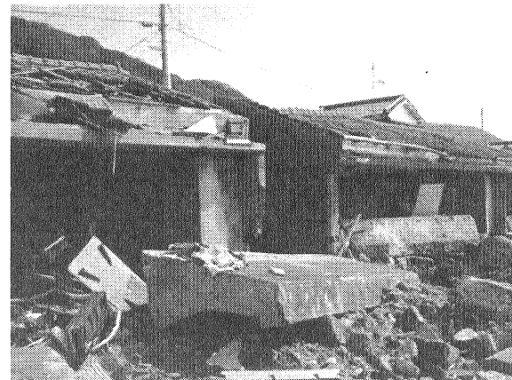
写真-5 海側から見た被災護岸の写真
