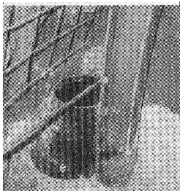
写真-1 パイプ式ウィングリブ設置状況
