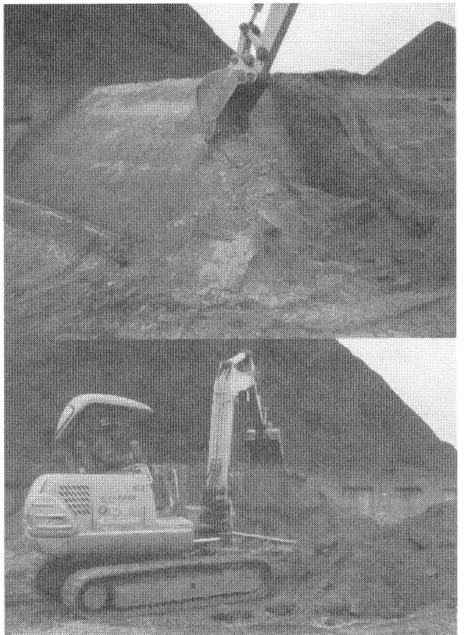
写真-8 盛土施工試験 (12ヶ月経過後、取り崩し状況：第1回施工)
