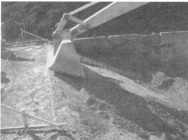
写真-5 盛土施工試験 (法面成形状況：第1回施工)
