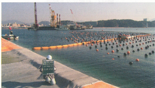
写真-12 遮水シート沈設状況
