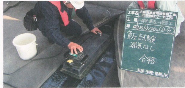
写真-7 負圧検査状況
