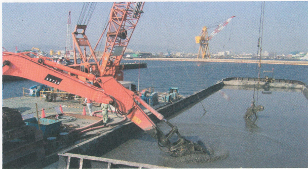
写真-13 解泥状況
