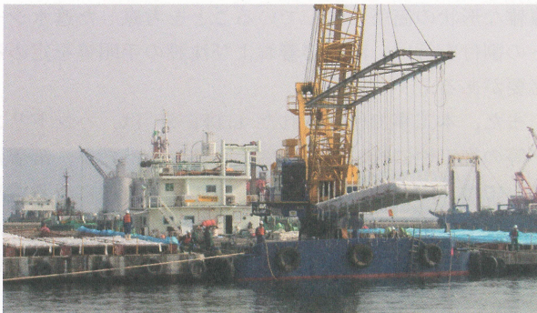
写真-17 布製型枠(打設済)据付状況
