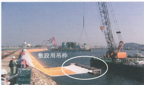
写真-14 布製型枠敷設状況
