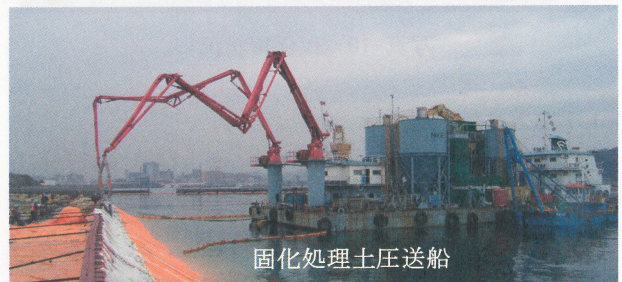
写真-15 布製型枠内打設状況
