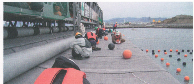
写真-8 ブイ取付状況
