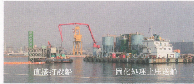
写真-18 直接打設状況図
