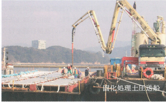
写真-16 布製型枠内打設状況
