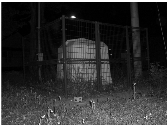
写真-2 K-NET 八戸における常時微動計測状況
