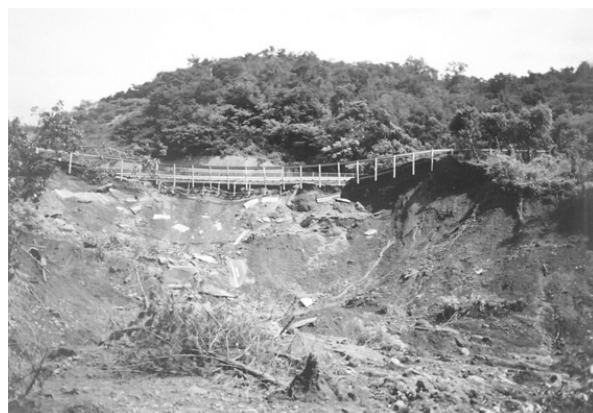
写真-1 山陽自動車道の崩壊 2)
