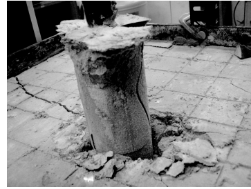
写真-8 引張型の試験後のアンカー一体
