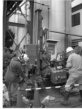
写真-7 調査状況
