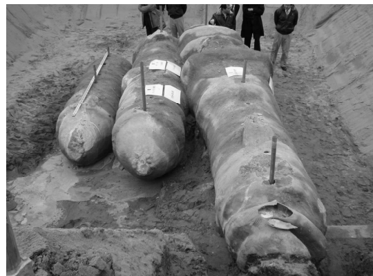
写真-4 掘り出した改良体
