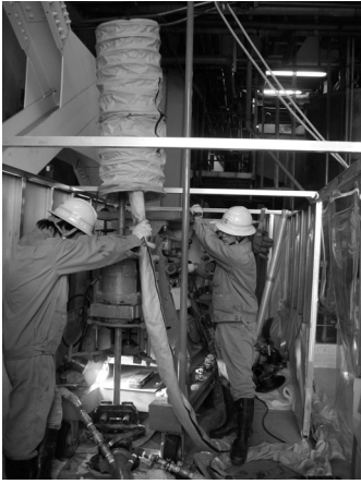
写真-6 工場内での施工状況
