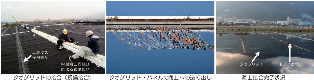
写真-4 ジオグリッド施工状況
