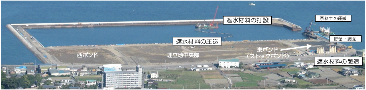
写真-1 土質遮水材料の施工状況
