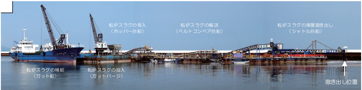
写真-5 覆砂工施工状況
