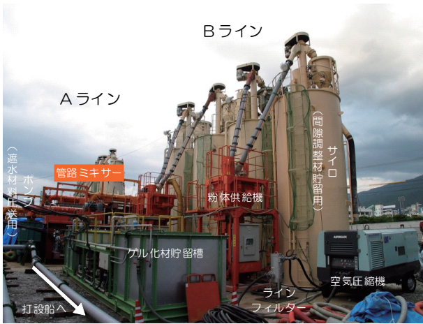
ポンプによる遮水材料の圧送 (④)
