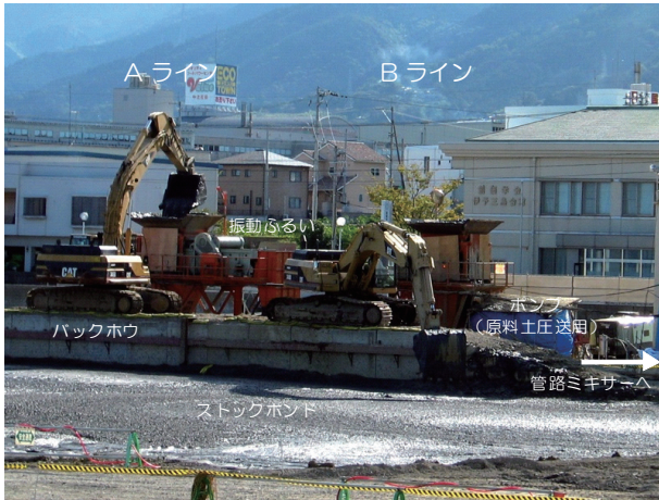
振動ふるいへの原料土の投入 (①、②)
