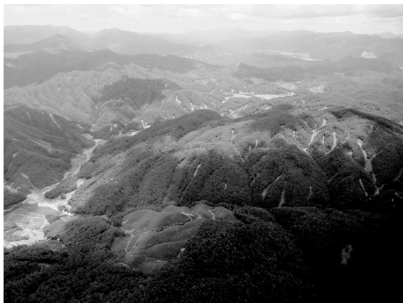
写真-3 広島県庄原市周辺の土石流等の集中発生状況 (2010年7月18日撮影, 庄原市川北町篠堂川)
