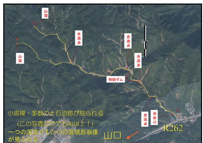
図-3 勝坂地区の崩壊・土石流発生状況
