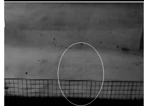
写真-3 亀裂の挙動 2)
