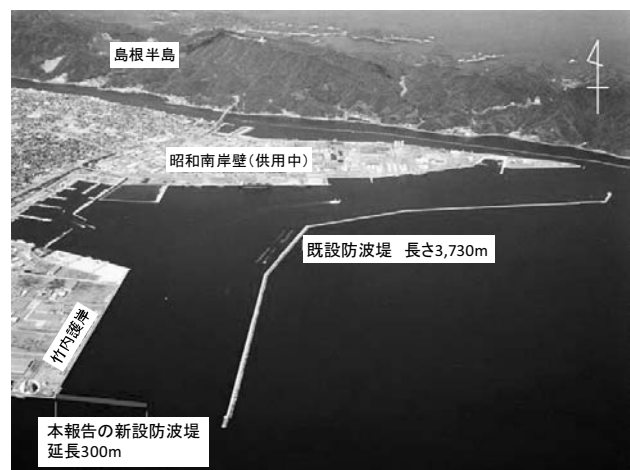
写真-1 境港湾の現況と新設防波堤の位置 (H18.5 撮影)
