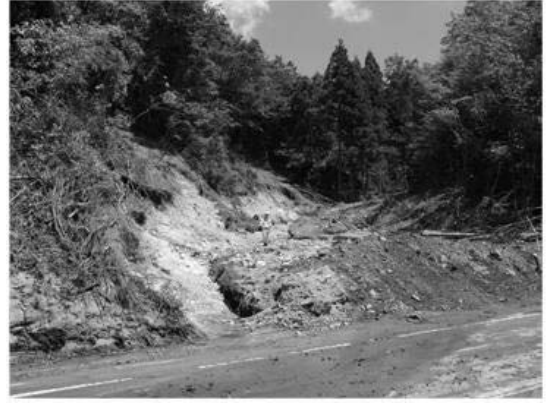
写真-21 溪流出口付近の状況 (手前は県道 445 号線)
