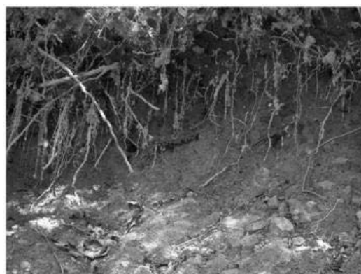
写真-28 源頭部付近における地盤内の孔
