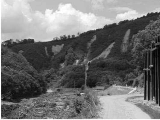
写真-20 溪流出口付近の斜面崩壊状況
