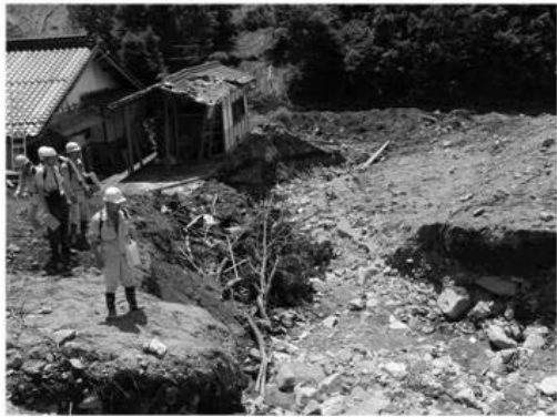
写真-22 県道 445 号線から篠堂川の状況 (左は半壊の家屋、右の家屋は全壊して篠堂川に流された)
