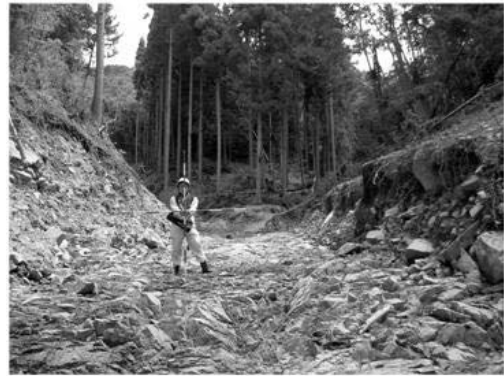
写真-23 溪流の出口付近 (幅は 10m、溪流の側面にはレキを含む厚さ約 3m の堆積層)
