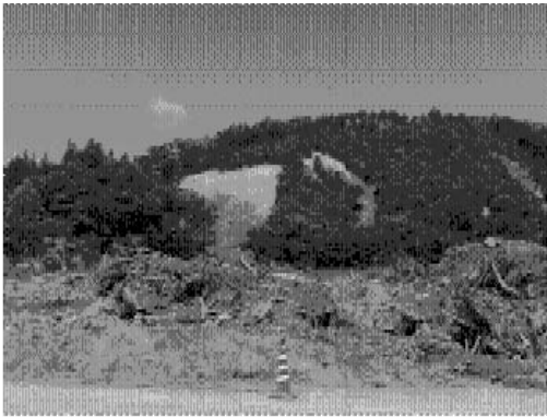
写真-14 先大戸地区の斜面崩壊
