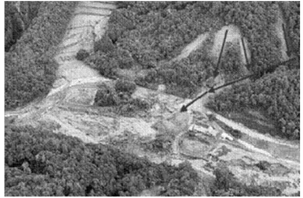
写真-9 篠堂川右岸で発生した土石流の状況
