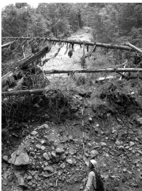
写真-24 溪流の側面の斜面からの表層崩壊による土砂と流木の流入
