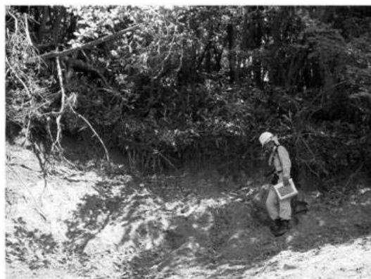
写真-27 源頭部の状況。表土と下部の岩盤層の間ですべりが生じている
