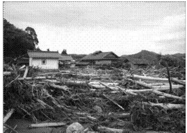
写真-11 先大戸地区における土石流、流木と家屋の被害（位置は図-2の④）
