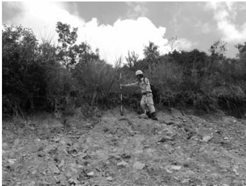
写真-16 崩壊斜面の頭部
