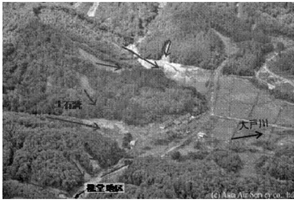
写真-10 先大戸地区における土石流と家屋の被害
