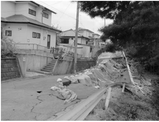
写真-9 道路と宅地の被害 (常時微動観測点③付近)
