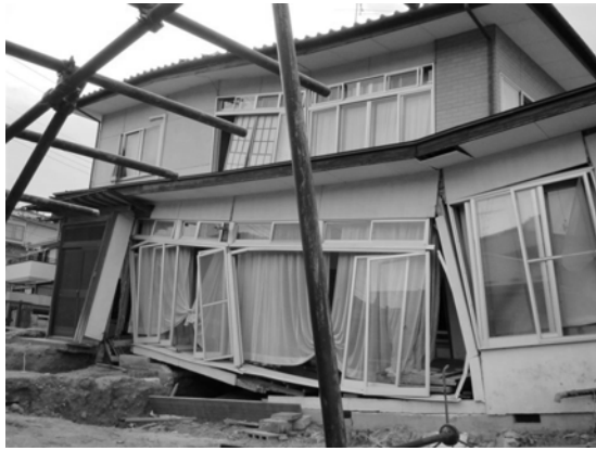
写真-3 家屋の被害 (折立5丁目)
