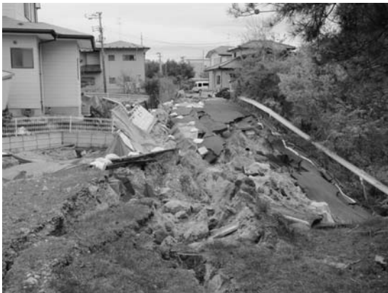
写真-10 道路と宅地の被害 (常時微動観測点④付近)
