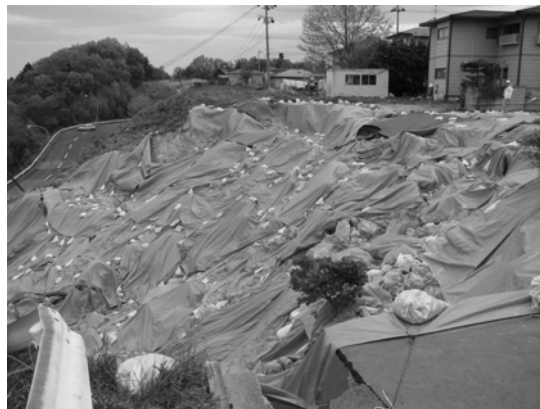
写真-8 盛土法肩部の被害 (常時微動観測点①付近)
