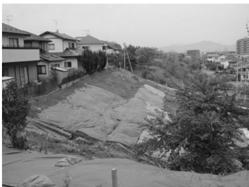
写真-6 長大法面の被害 (南光台6丁目)
