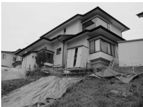
写真-7 法肩部の家屋被害 (南光台6丁目)
