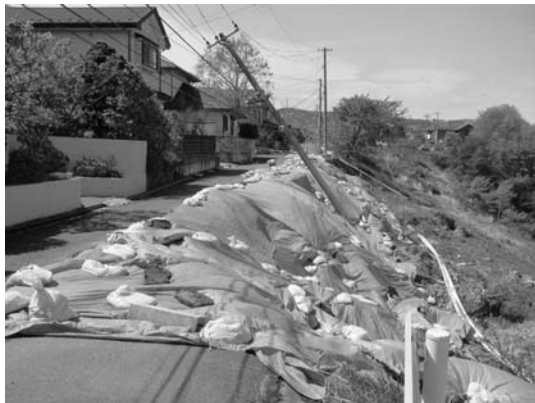
写真-5 外周道路の被害(北中山3丁目)
