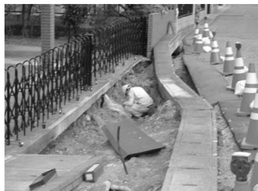
写真-2 道路の被害 (折立5丁目)
