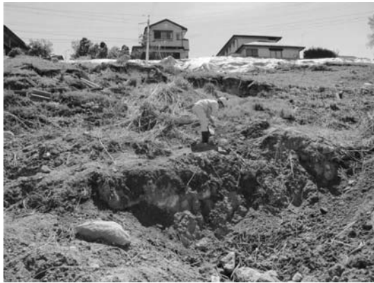
写真-4 長大法面の被害(北中山3丁目)
