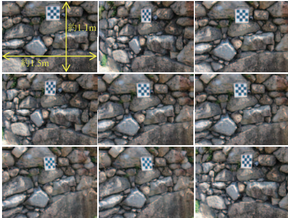
写真-1 解析に用いた石積み擁壁の画像
