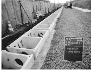
写真-6 枠ブロック設置
