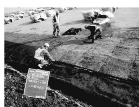
写真-3 侵食防止シート設置
