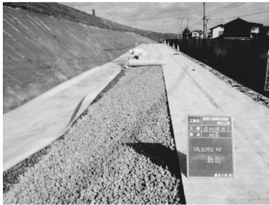
写真-8 シートの敷設
