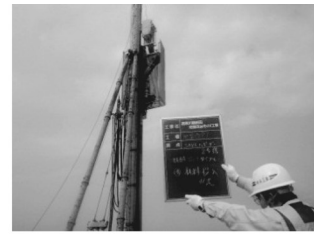
写真-13 ケーシングへの砕石注入
