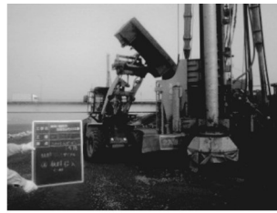
写真-12 砕石の投入
