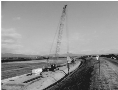
写真-20 鋼矢板設置中
