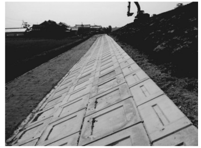
写真-19 平張ブロック設置
