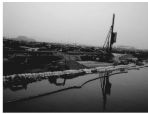
写真-11 施工機械の配置
