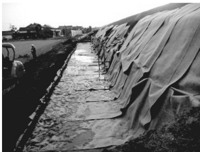
写真-17 堤防の開削
