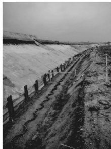
写真-21 鋼矢板設置済み
