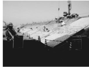
写真-16 表面ブロック設置
