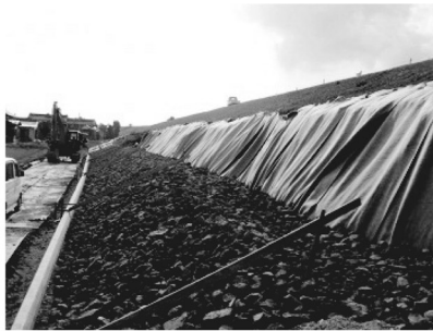
写真-18 砕石の設置
