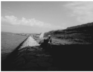
写真-10 施工前の高水敷
