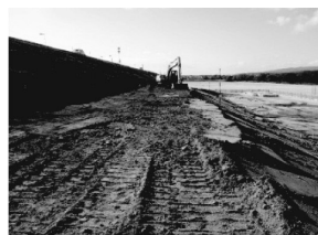
写真-2 盛土作業
