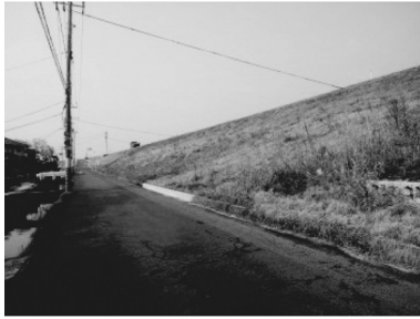
写真-5 ドレイン工施工前
