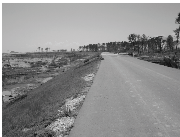
写真-1 井土浦での河川堤防の被災状況(川表側)
