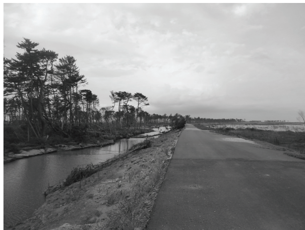
写真-2 井土浦での河川堤防の被災状況(川裏側)
