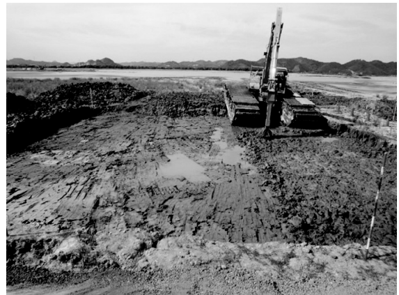
写真-6 実験ヤードの造成状況 (加水攪拌により所定の強度を有する粘性土地盤の造成)
