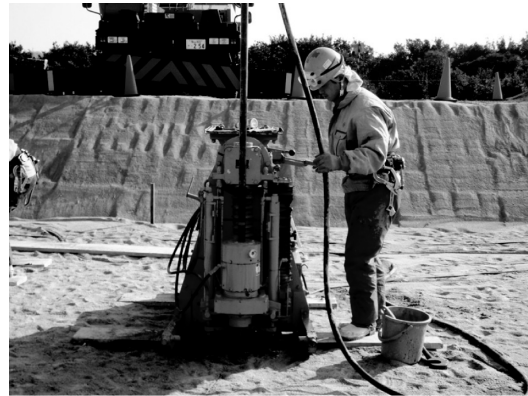
写真-7 水ジェットによる加水攪拌の作業状況
