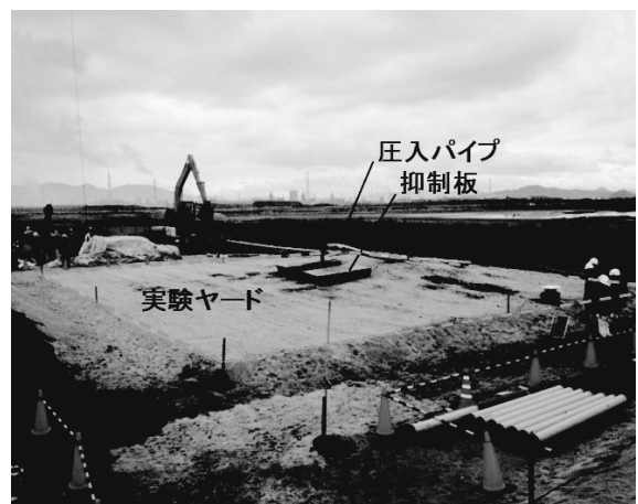
写真-8 圧入作業
