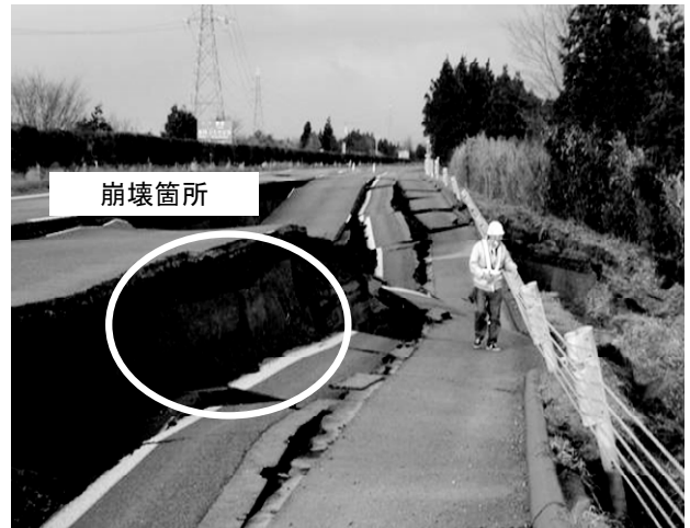
写真-1 対象盛土の被害状況 7)
