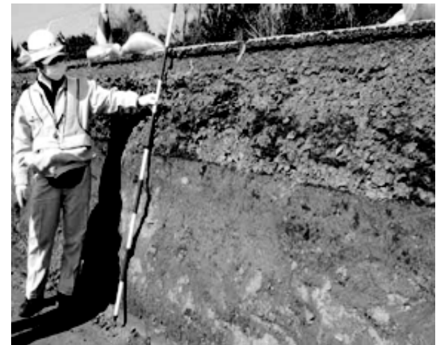
写真-2 対象盛土の被害状況 8)
