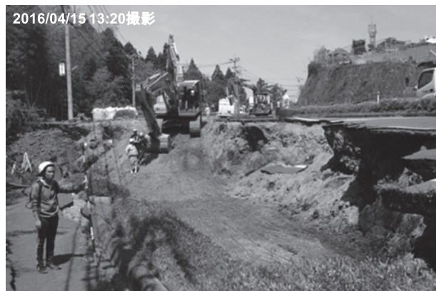
写真-1 道路盛土の被災状況(益城町寺迫交差点北側) 1)
