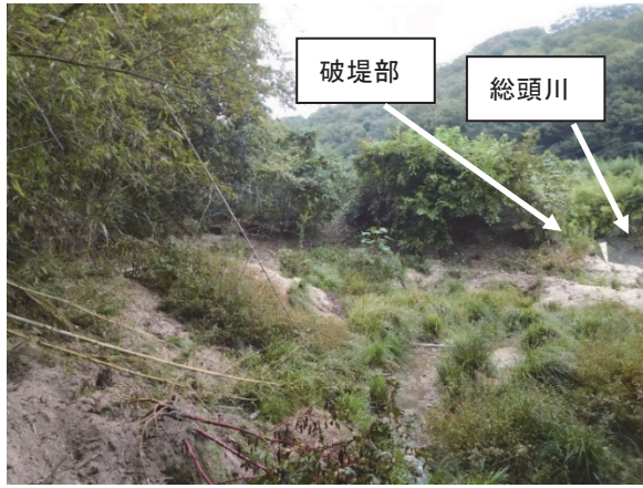
写真-4 被災ため池の状況 (d地点の南西方向より)
