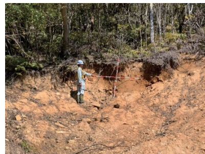
写真-2 源頭部のパイピング跡
