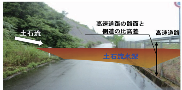
図-5 高速道路横過部における高速道路路面と溪床の比高差
