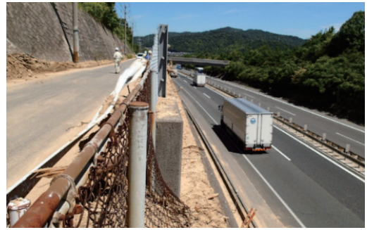
写真-1 土石流の流入を防止した既設落石防護工事事例
