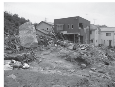
図-1 住宅に衝突した巨礫を含む土石流 2)
