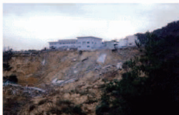
(a) 1995 年兵庫県南部地震時の西宮市内
