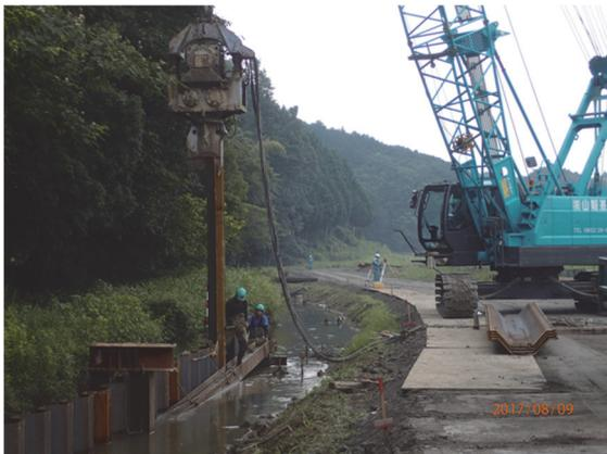
写真-6 鋼矢板打設状況
