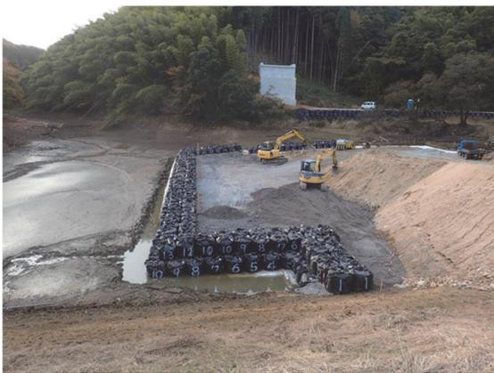
写真-2 底泥撤去状況
