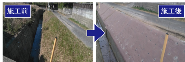
写真-7 水路周辺補強・防草対策工事の施工前後の状況
