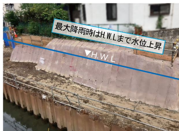
写真-9 大雨後の水和硬化性マット養生箇所状況
