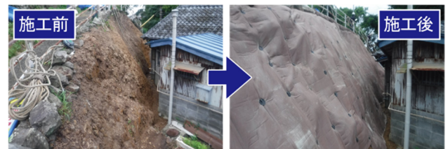
写真-5 民家隣法面保護工の施工前後の状況
