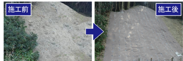
写真-4 鉄道沿い法面保護工の施工前後の状況
