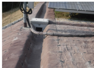
写真-6 素掘側溝排水路補強工事の施工後の状況
