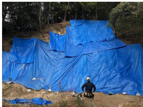
写真-1 ブルーシートで養生された斜面崩壊現場
