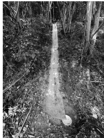
写真-12 簡易排水工の設置
