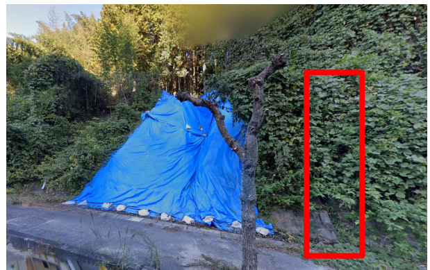
写真-15 ブルーシートによる斜面保護
