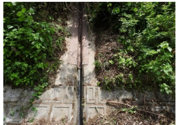
写真-18 水和硬化性マット設置
